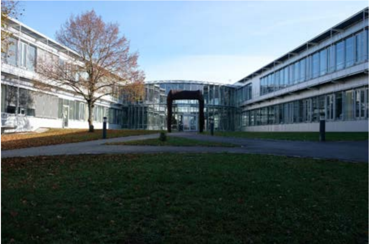
[1] Bestandsgebäude Allmandring 31, Eingangsbereich - Westseite
