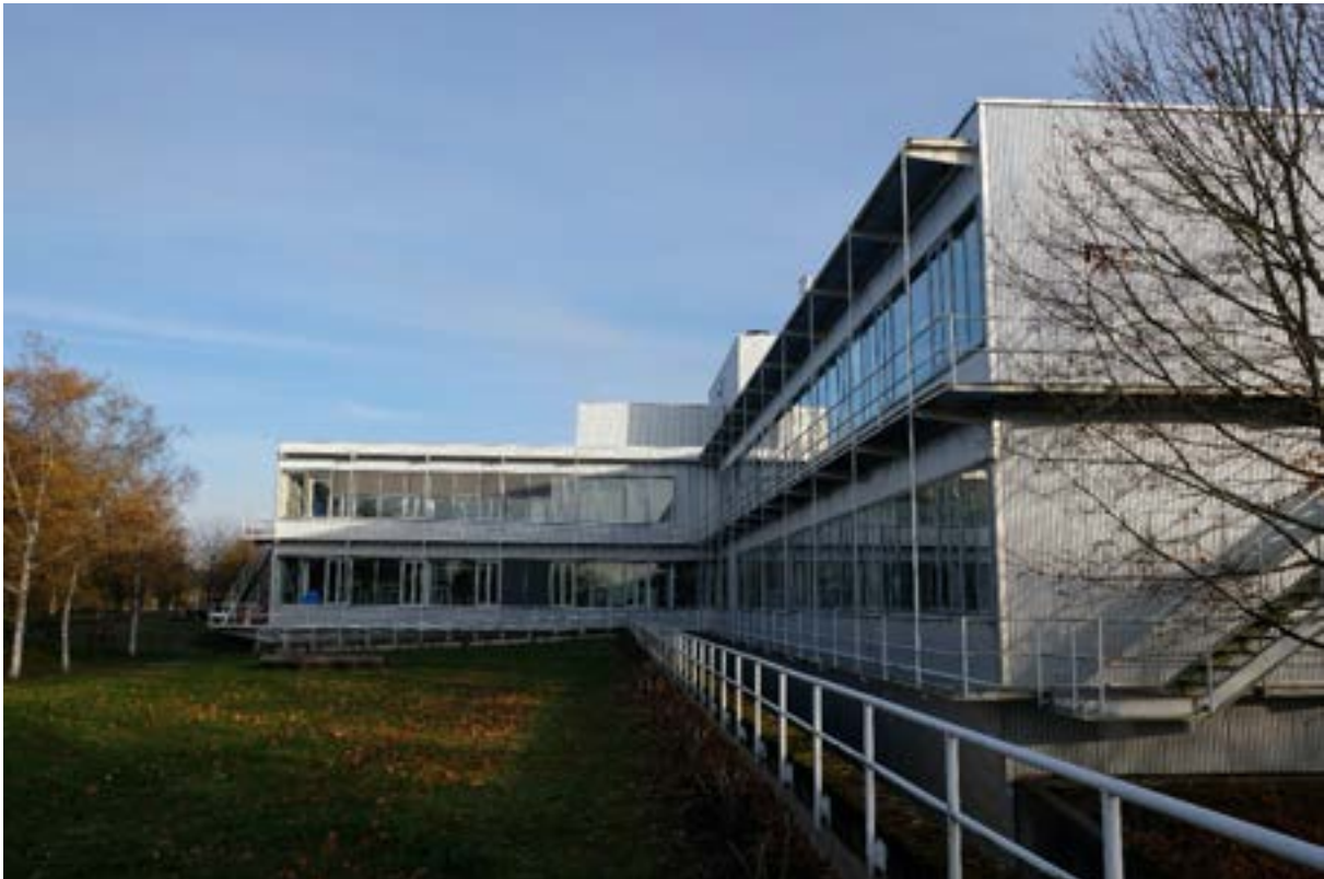
[4] Bestandsgebäude Allmandring 31, Laborbereich - Versuchshalle - Westseite
