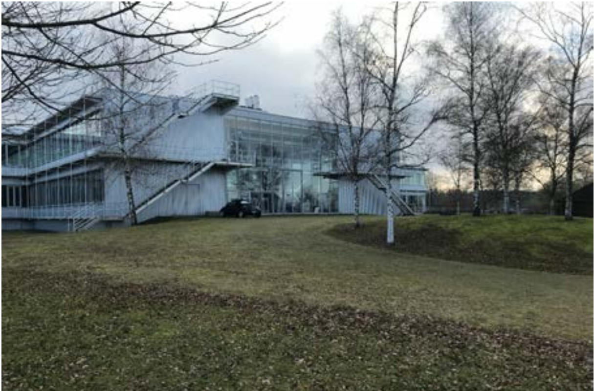
[5] Bestandsgebäude Allmandring 31, Versuchshalle - Nordseite
