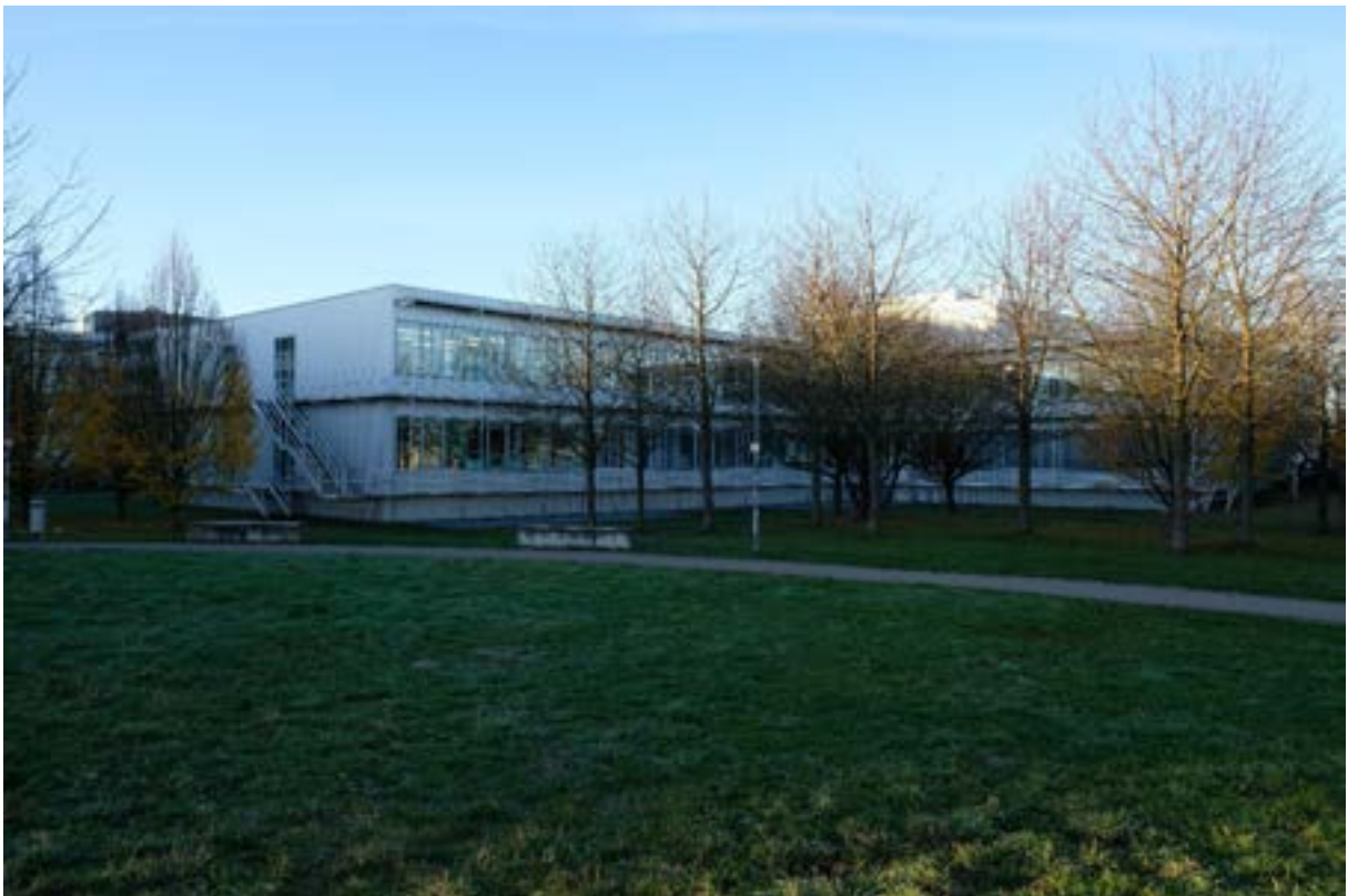
[6] Bestandsgebäude Allmandring 31, Laborbereich - Versuchshalle - Nord-Ostseite
