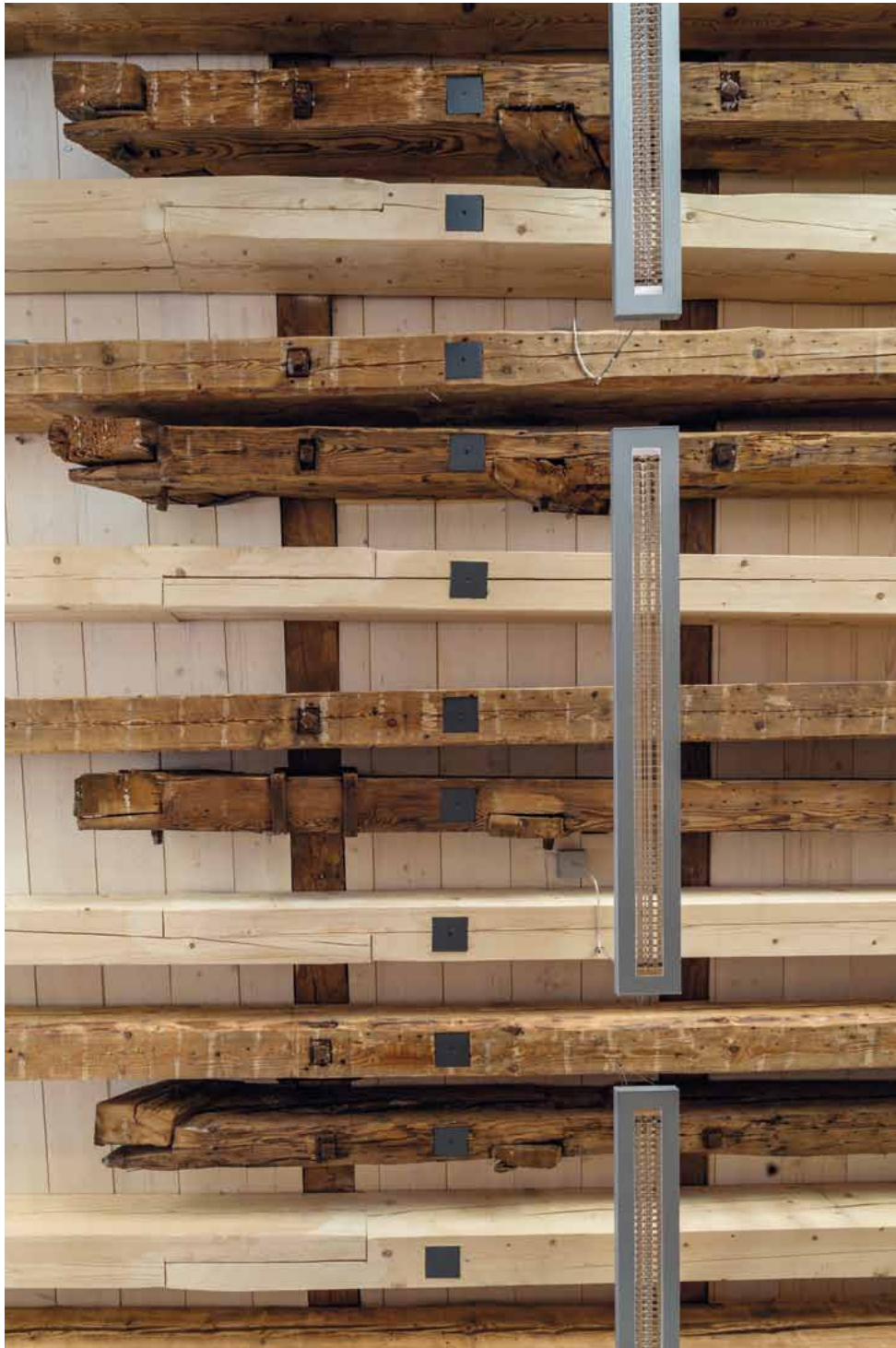
Musiksaal Deckenuntersicht mit Hölzern aus verschiedenen Zeiten
